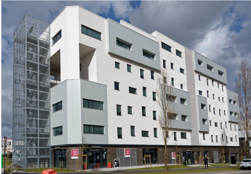
Figure 3 : Façade du Nantes Liberty Center
